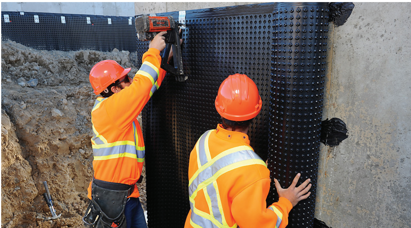
INSTALLATION DE PLATON - MURS DE FONDATION
