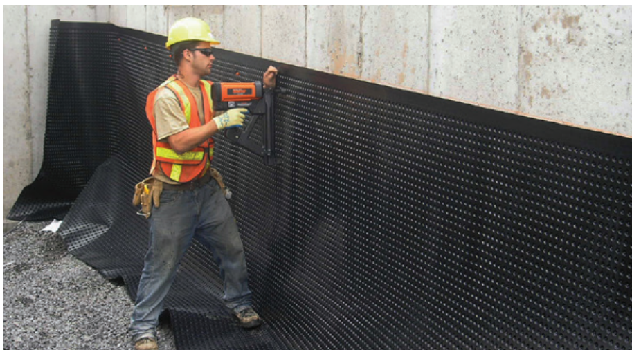
INSTALLATION DE PLATON - MURS DE FONDATION
