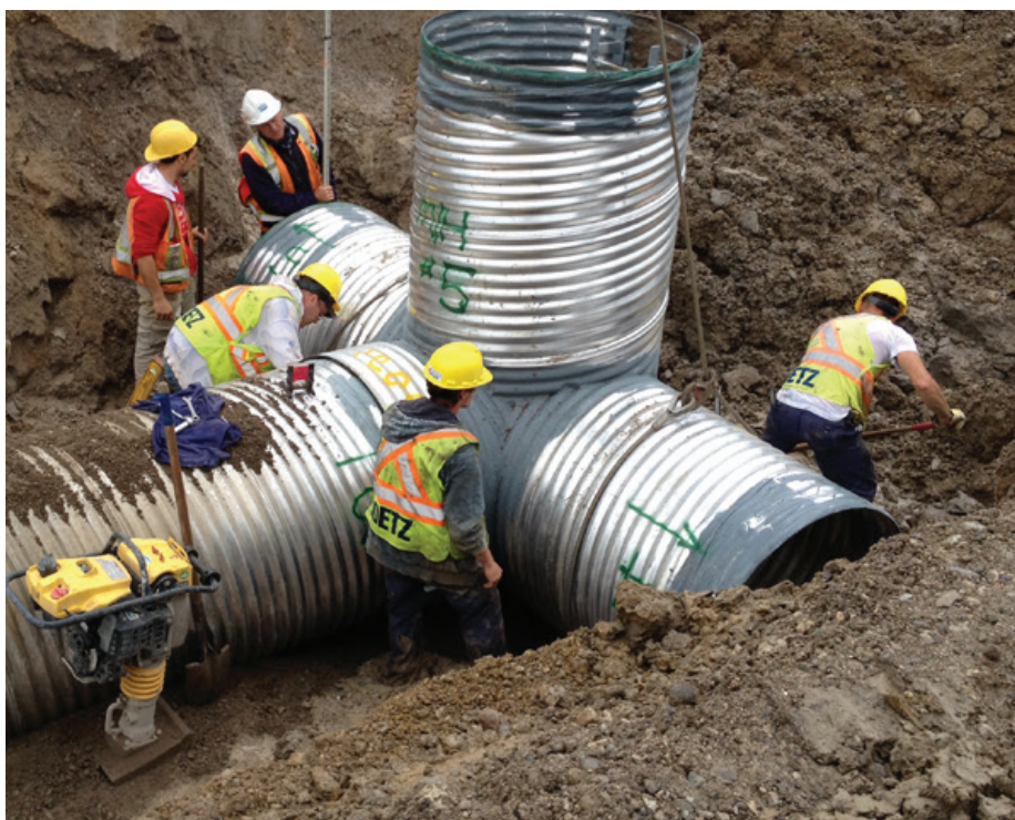
LES SECTIONS LÉGÈRES DE TUYAU STEELCOR PERMETTENT UNE INSTALLATION SANS ÉQUIPEMENTS LOURDS
