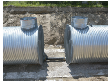
SYSTÈME DE RÉSERVOIRS D'EAU PLUVIALES EN TTO GALVANISÉ
