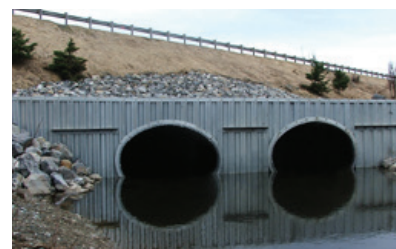
MURS DE TÊTE / PARAFOUILLE EN PALPLANCHES
