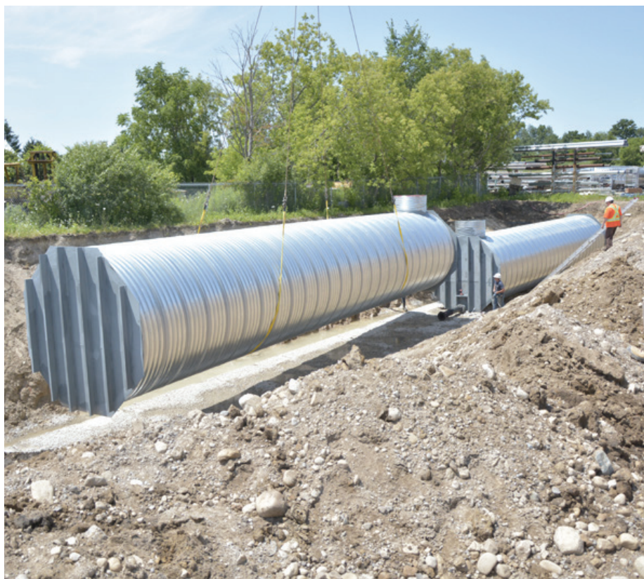
SES ONDULATIONS HÉLICOÏDALES ET SON JOINT AGRAFÉ CONTINU LUI CONFÈRENT UNE RÉSISTANCE ÉLEVÉE DANS UNE STRUCTURE LÉGÈRE
