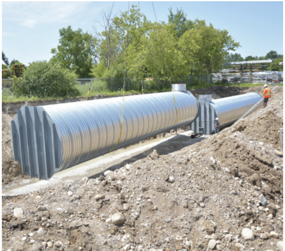
SES ONDULATIONS HÉLICOÏDALES ET SON JOINT AGRAFÉ CONTINU LUI CONFÈRENT UNE RÉSISTANCE ÉLEVÉE DANS UNE STRUCTURE LÉGÈRE
