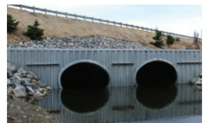
MURS DE TÊTE / PARAFOUILLE EN PALPLANCHES
