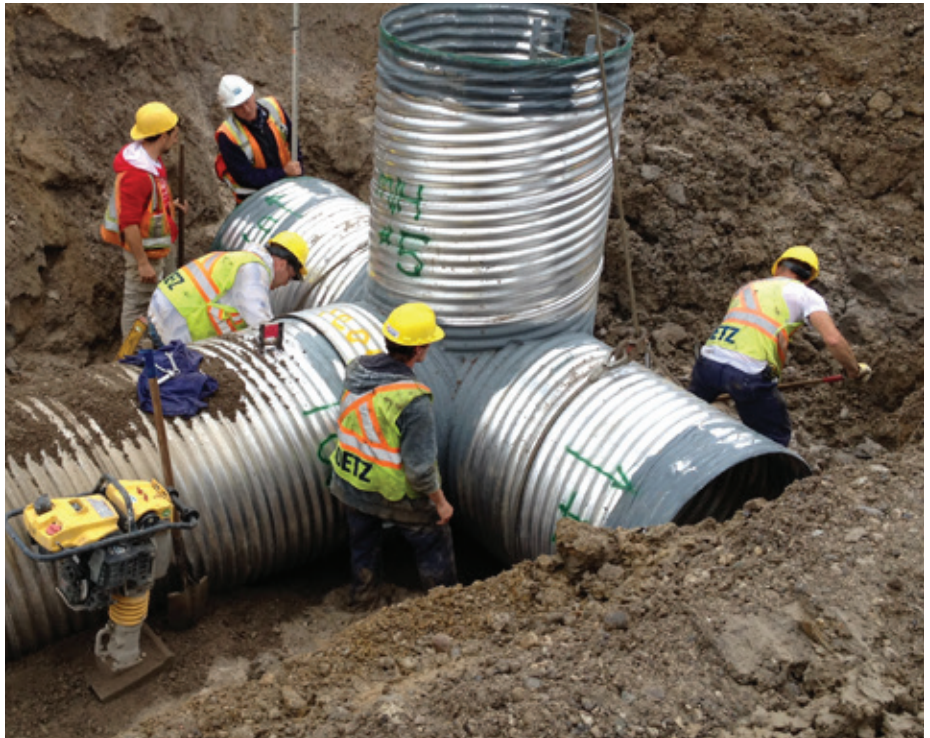
LES SECTIONS LÉGÈRES DE TUYAU STEELCOR PERMETTENT UNE INSTALLATION SANS ÉQUIPEMENTS LOURDS
