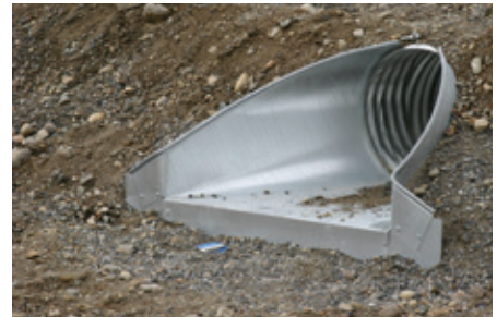
TABLIERS DE PONCEAU DE TUYAU EN TÔLE D'ACIER AVEC PARAFOUILLE
