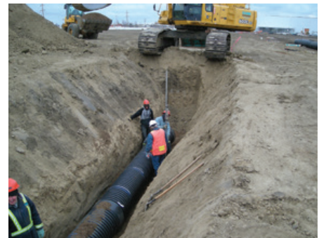
REMBLAYAGE D'UNE TRANCHEE CONTENANT UN TUYAU BOSS 2000
