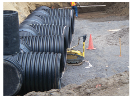
PRÉPARATION DU SOL POUR L'INSTALLATION D'UN TUYAU EN PEHD
