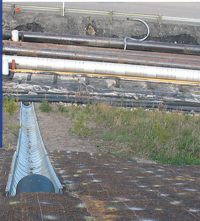
DALOT SEMI-CIRCULAIRE SOUTENU PAR DES LISSES DE BOIS
