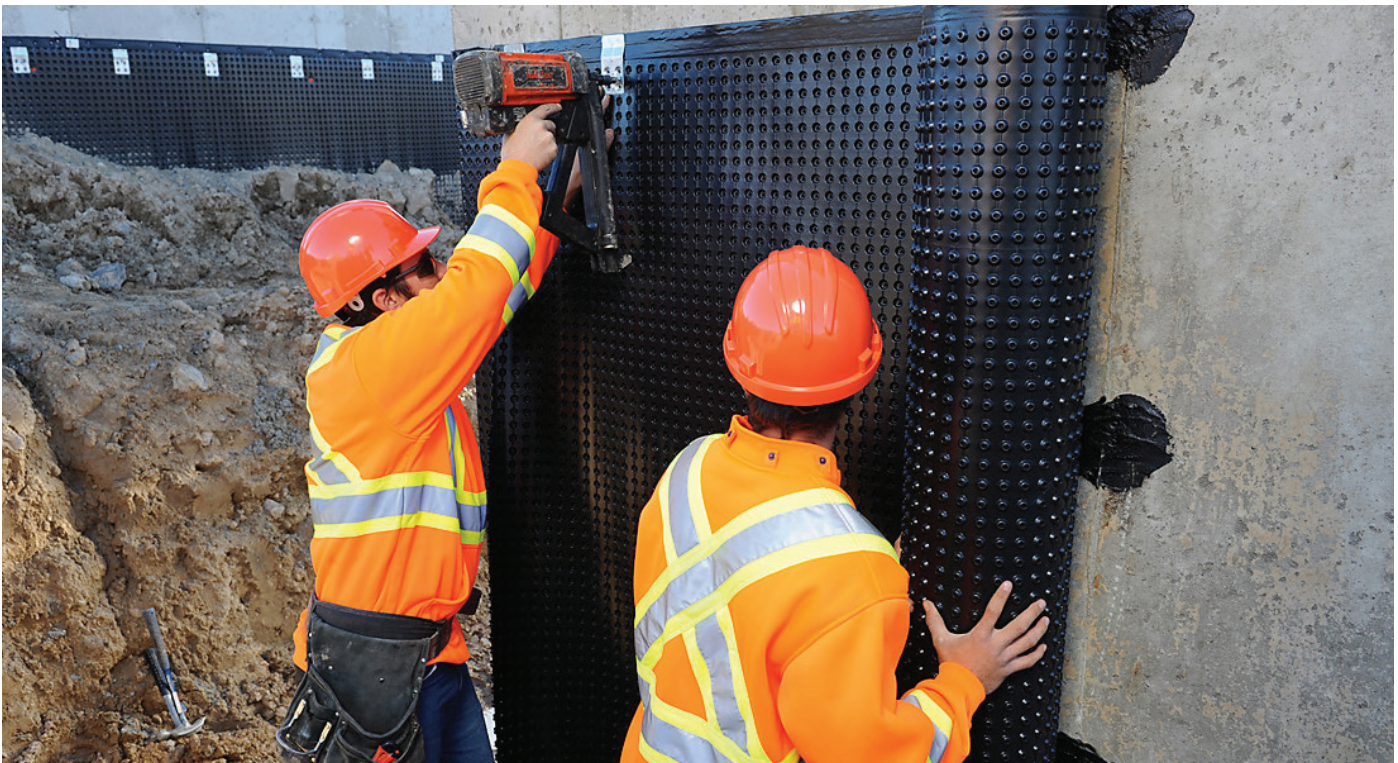
INSTALLATION DE PLATON - MURS DE FONDATION
