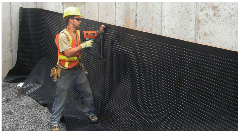
INSTALLATION DE PLATON - MURS DE FONDATION
