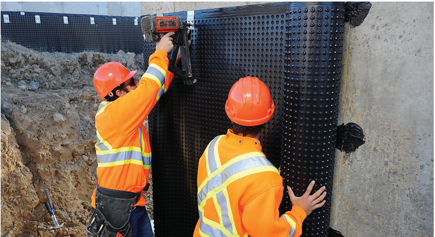
INSTALLATION DE PLATON - MURS DE FONDATION
