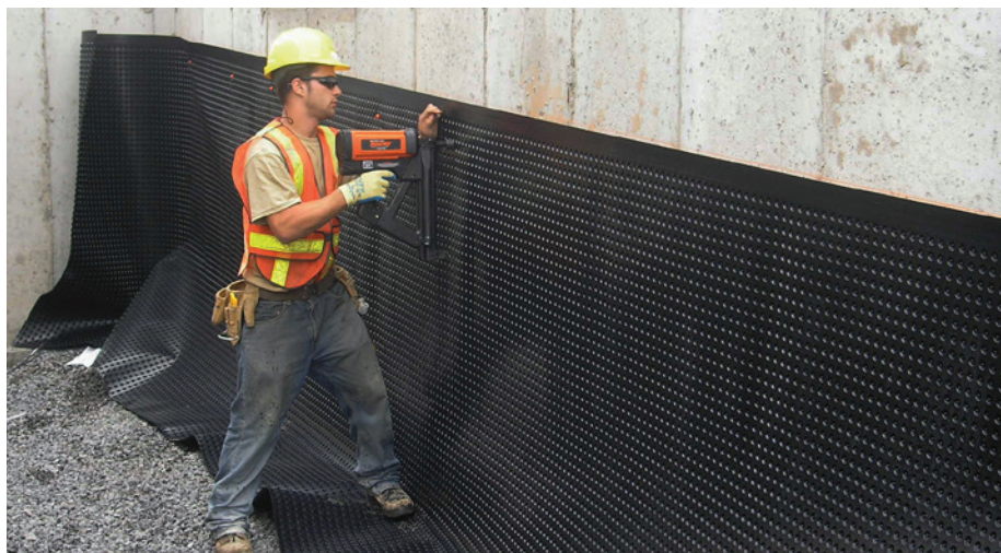
INSTALLATION DE PLATON - MURS DE FONDATION
