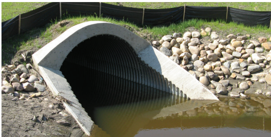
EXTRÉMITÉ BISEAUTÉE AVEC COLLIER DE BÉTON ARMÉ
