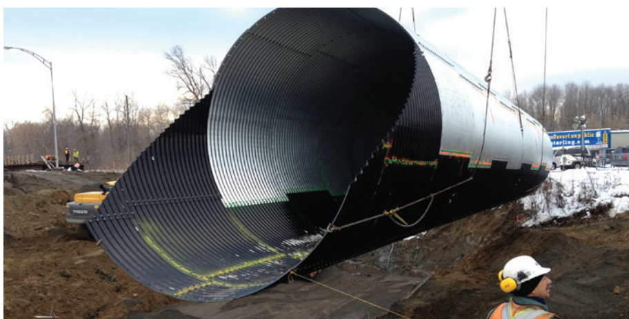
LE REVÊTEMENT EN COPOLYMÈRE DE TYPE STRATA-CAT OFFRE UNE PROTECTION SUPPLÉMENTAIRE DANS LES MILIEUX AGRESSIFS.
