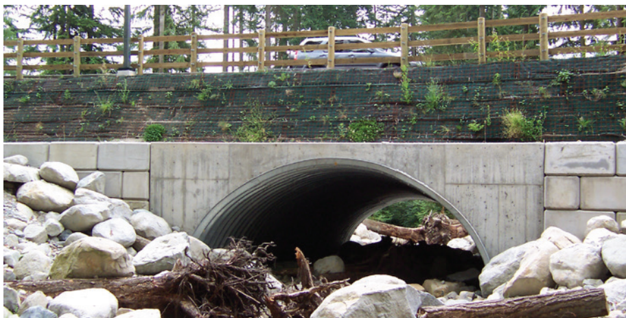
MUR DE TÊTE COULÉ EN PLACE AVEC MUR DE D'AILES EN BLOCS SEGMENTAIRES
