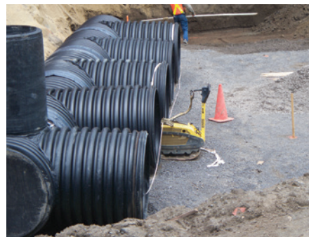
PRÉPARATION DU SOL POUR L'INSTALLATION D'UN TUYAU EN PEHD
