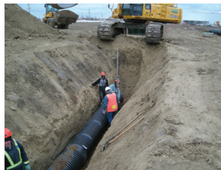
REMBLAYAGE D'UNE TRANCHEE CONTENANT UN TUYAU BOSS 2000
